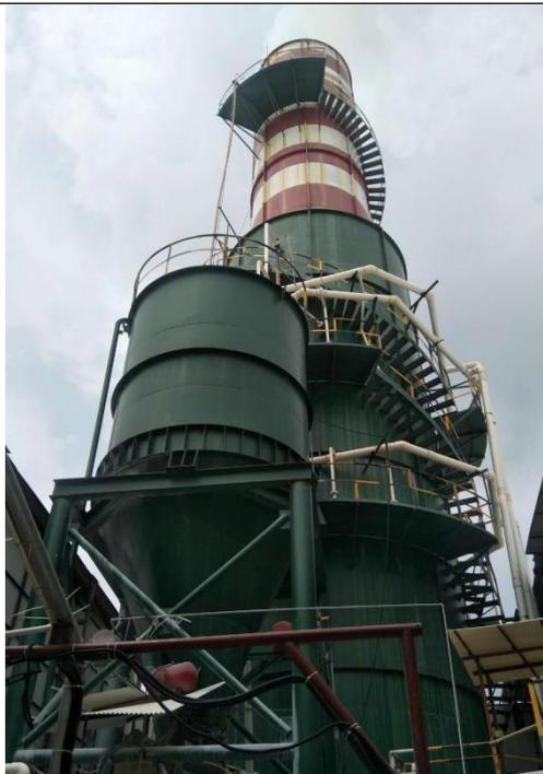
辊道窑烟气除硫除尘处理
